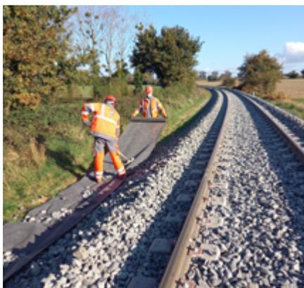
Le **ROOTGUARD™** est un géotextile monofilament polypropylène / polyéthylène thermolié. Il offre une excellente résistance au développement des racines ; confirmé dans de nombreux essais et chantiers.
